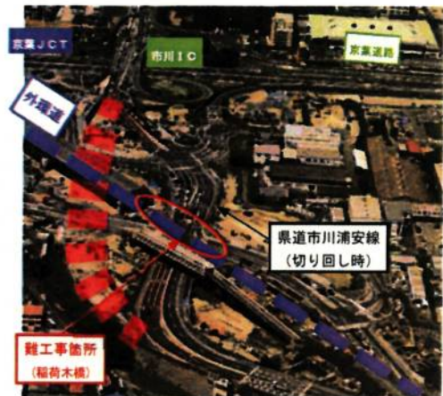
■県道市川浦安線の切り回し状況
